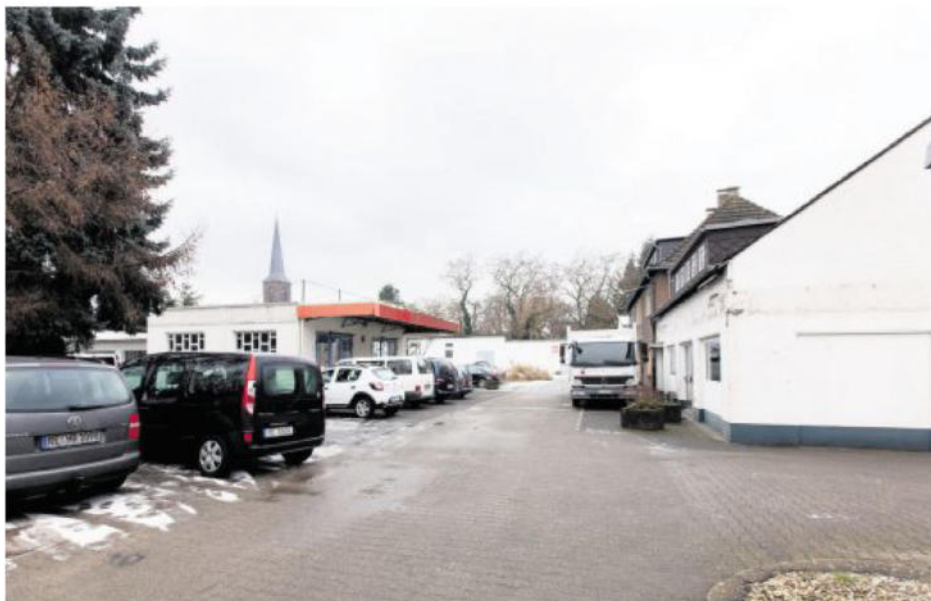
Noch stehen einige Gebäude im Innenhofbereich an der Düppelstraße, doch schon in wenigen Tagen werden die Abbrucharbeiten beginnen.
