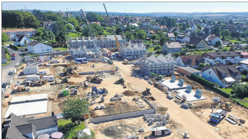
Bauarbeiten gehen schnell voran: Auf dem Areal der ehemaligen Molkerei Lindenberg sind bereits gut die ersten Rohbauten des Wohnparks zu erkennen. Foto: BehrJnh
