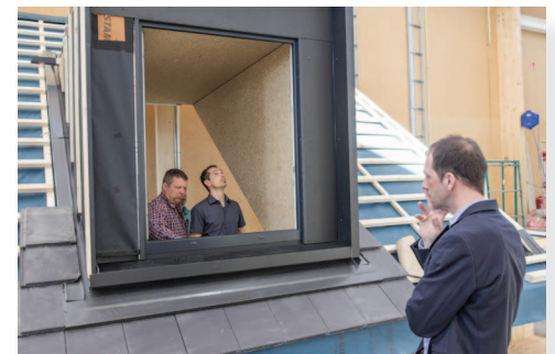
Alles wie geplant? Die Experten betrachten die neue Gaube im Detail.
