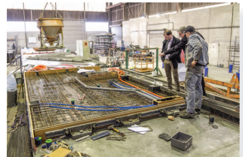
In der Fertigungshalle werden die tonnenschweren Elemente produziert.
