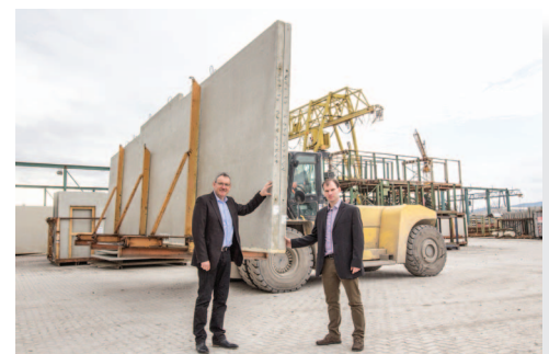
Die Wand ist fertig. Nun kommt sie zu den anderen auf dem Firmengelände von FDU.
