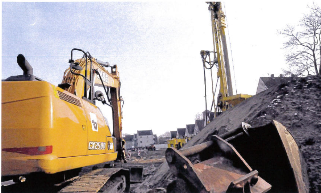
Blick auf die Baustelle in Alstedde. Innenverdichtung heißt das Stichwort für das Projekt.
