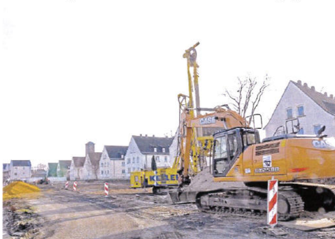
Seit Montag wird „Am Urnenfeld“ in Alstedde gearbeitet. Um hier 30 Reihenhäuser errichten zu können, muss zunächst der Boden verdichtet werden. Diese Arbeiten sollten am Freitag abgeschlossen sein.
