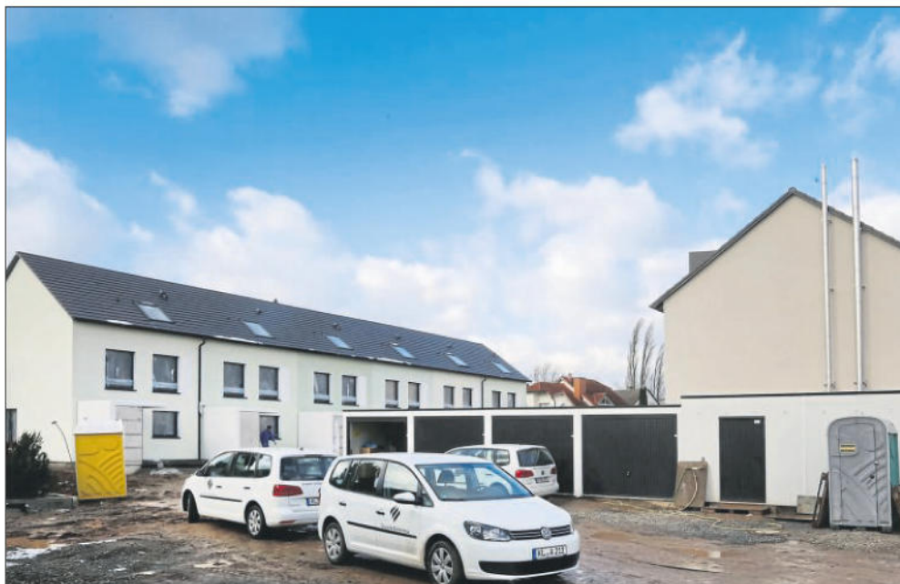
Wohnpark „Am Jungfernkopf“: Die 27 Reihenhäuser sind fertiggestellt und stehen zum Verkauf. Rechts neben den Garagen, von denen es insgesamt 18 und zudem 25 Autostellplätze gibt, steht die Technikzentrale der neuen Siedlung. Foto: Schachtschneider
