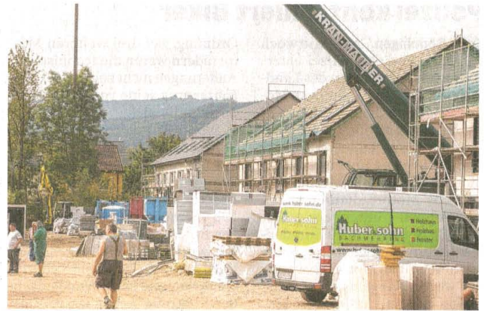
34 Reihenhäuser werden im neuen Wohnquartier „Falbenäcker“ in Süßen gebaut.
