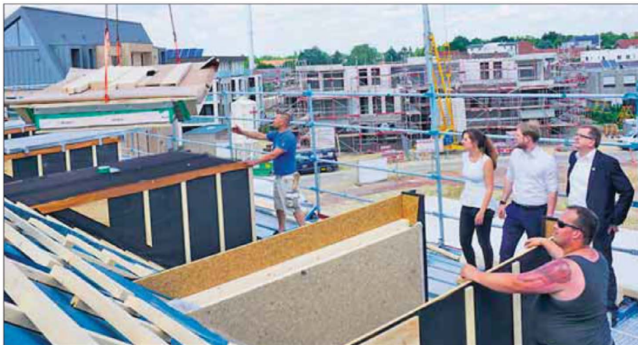
Mit einem großen Kran werden die vorproduzierten, tonnenschweren Dachelemente direkt vom Lkw auf die Häuser gesetzt.
