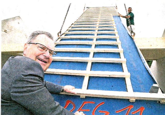
Bürgermeister Ernst Lauterjung packt auf der Baustelle an der Allgäustraße mit an. FOTO: KÖHLEN
